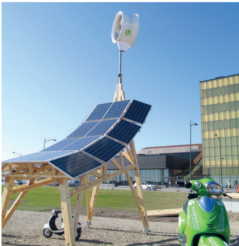
"Giraffen", ett kombinerat energiverk för vind- och solkraft strax intill Emporia i Hyllie centrum. Här kan man ladda mobiltelefon och andra eldrivna prylar.
